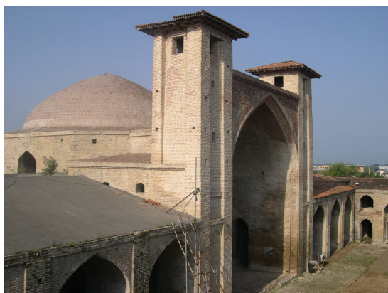
تصویر ۵- مسجد مدرسه فرح آباد بعد از مرمت (URL5)
