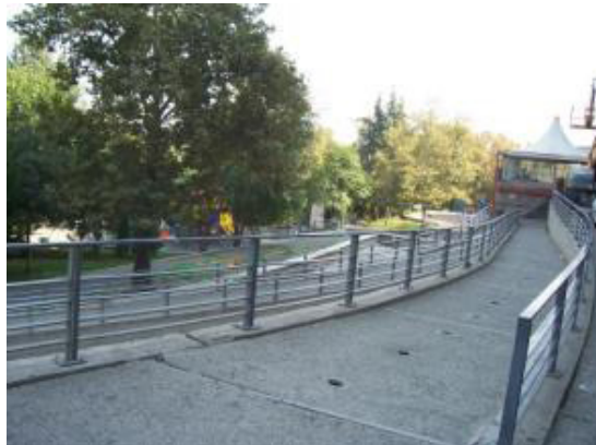
تصویر ۱۷. امتداد رمپ‌های داخلی بنا به فضای بیرونی و حفظ حرکت پیوسته میان درون و بیرون.
