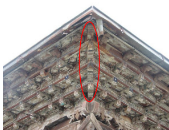
شکل ۸. قسمت کنج و زاویه‌دار سقف.
