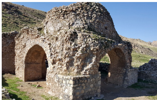
شکل ۱۶. نوع طاق و تکیه‌گاه‌های به‌کاررفته در بنای آتشکده سیاهگل.
