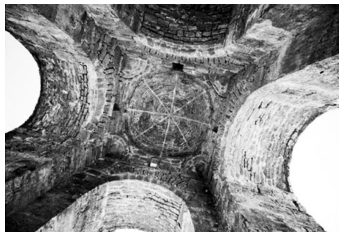
شکل ۳. شیوه پوشش چهارطاقی نیاسر با کمک تویزه گچی (گذار، ۱۳۷۱: ۳۱).
