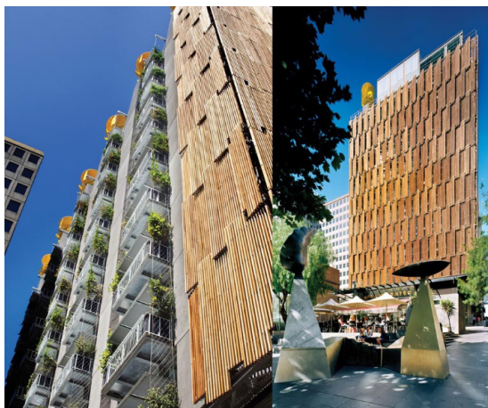
شکل ۱۲. خانه شورای شهر (معماری آرل، ۱۳۹۷).
