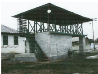
شکل ۱۷. نمای شمالی و غربی سقافار حمزه‌کلا- شش‌پل. آرشیو اداره کل میراث فرهنگی، گردشگری و صنایع دستی استان مازندران.
