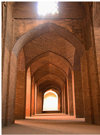
شکل ۶. پوشش بنا با سیستم طاق و تویزه (تجویدی، ۱۳۸۳: ۱۸).
